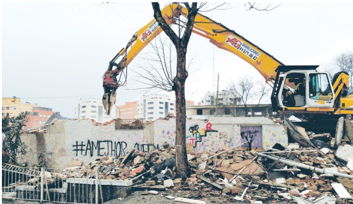
Derribo del antiguo local de Amejhor, en la UVA de Hortaleza, el pasado 21 de marzo. YOLANDA PEÑA
