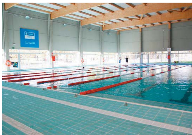
Piscina cubierta antes de la reforma. CDM HORTALEZA
