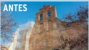
La ermita de San Blas en Canillas, antes y después de su restauración.
