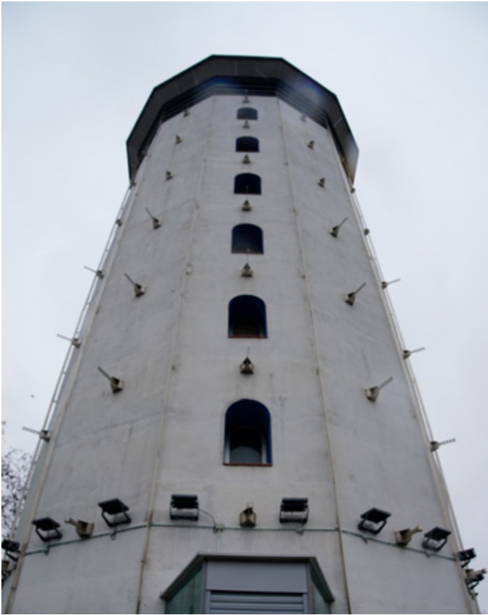
Perspectiva del Silo de Huerta de la Salud desde su entrada. PHOTOLEZA
