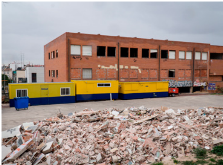
Obras en el edificio del Rubén Darío que albergará el proyecto. DAVID NAVARRO
