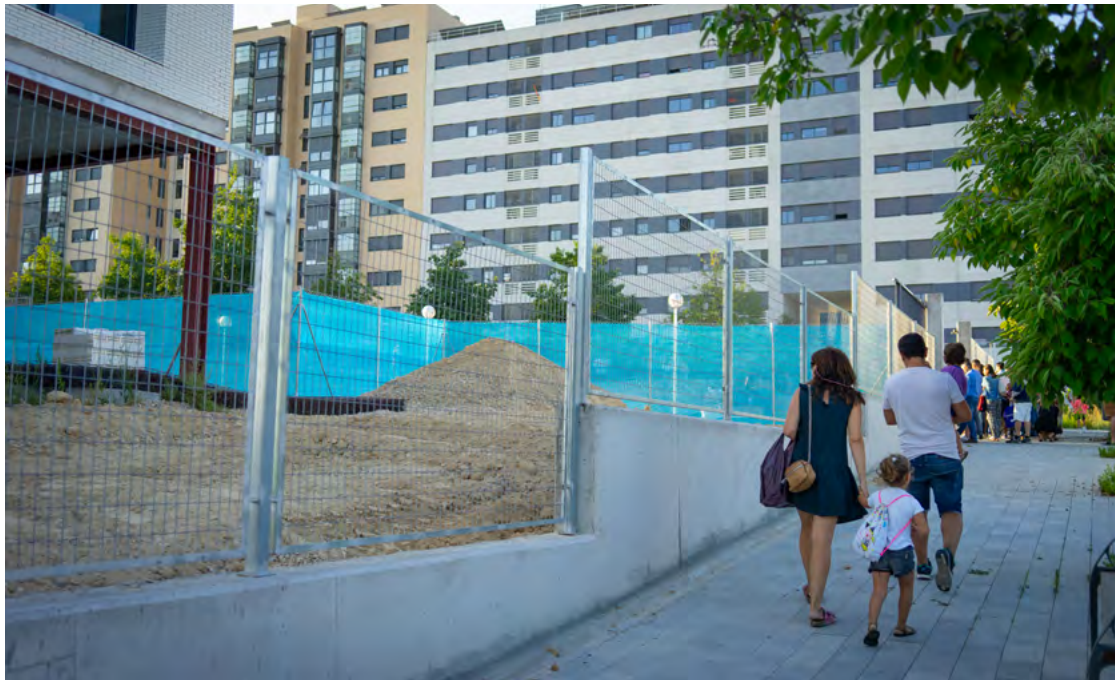
Obras en el colegio de Valdebebas el pasado mes de septiembre durante el día de la ‘vuelta al cole’. DAVID NAVARRO
