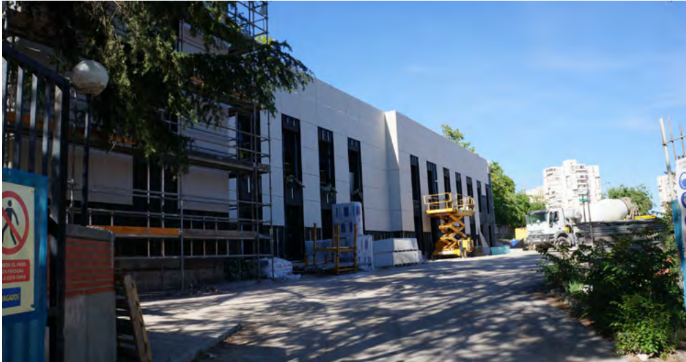
Estado de las obras del edificio de la futura Casa de las Asociaciones. ÁNGEL SÁNCHEZ
