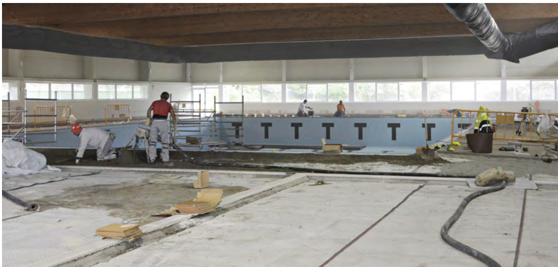
Obreros desarrollando los trabajos de mejora en la piscina cubierta del Centro Deportivo Municipal Luis Aragonés. PHOTOLEZA
