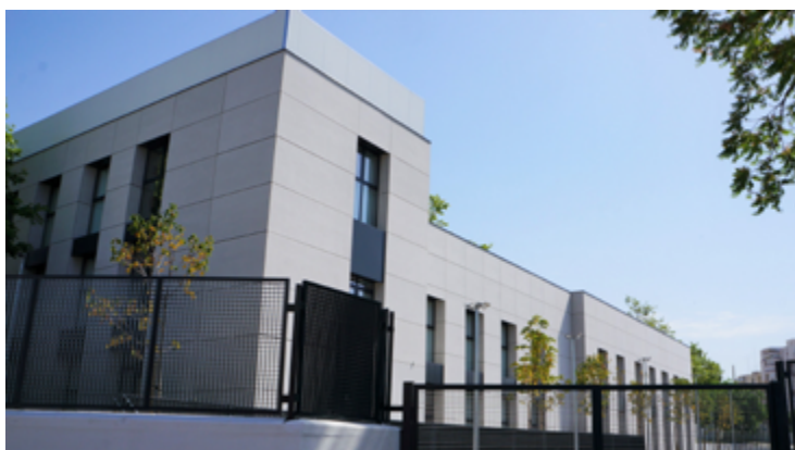
Estado del edificio del antiguo colegio público Rubén Darío previsto como Casa de las Asociaciones de Hortaleza. ÁNGEL SÁNCHEZ
