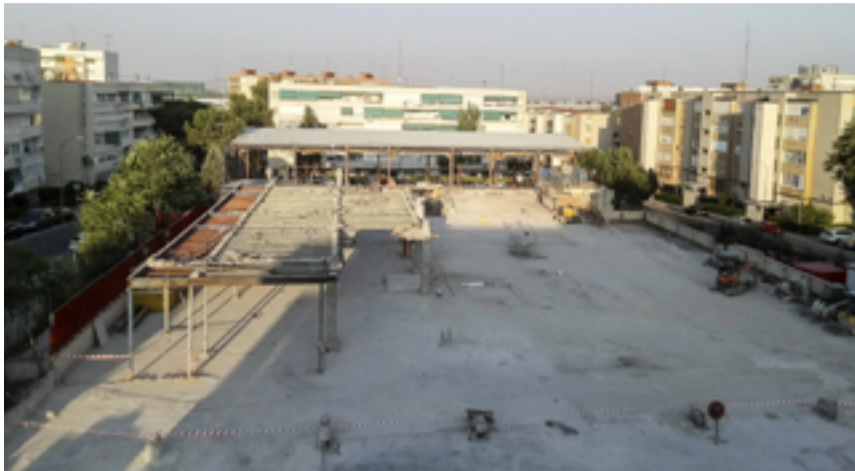
Vista aérea de la demolición de las plantas sobre rasante del antiguo gimnasio Fasán 2000. ÁNGEL SÁNCHEZ
