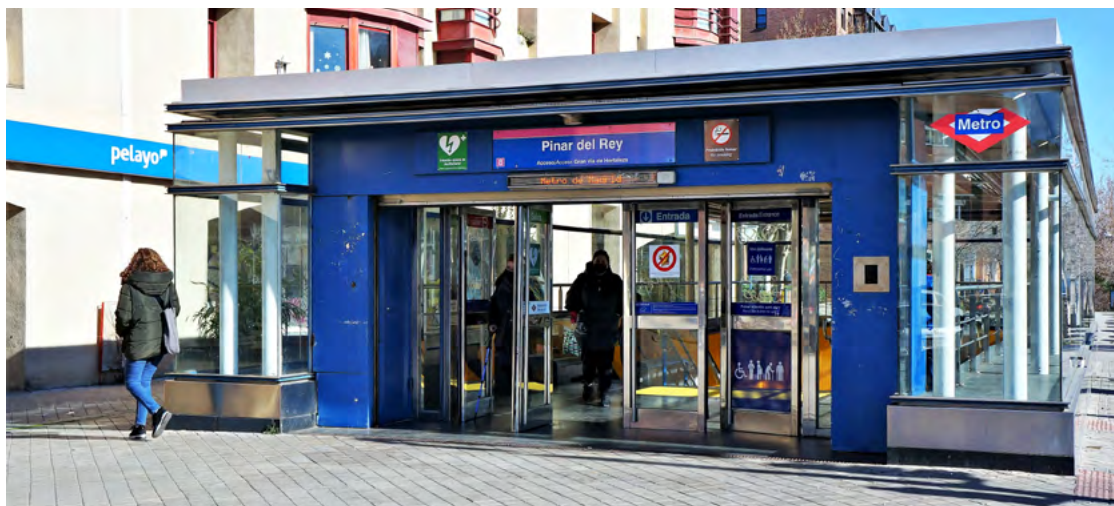
Entrada a la estación de Metro de Pinar del Rey. ÁNGEL SÁNCHEZ
