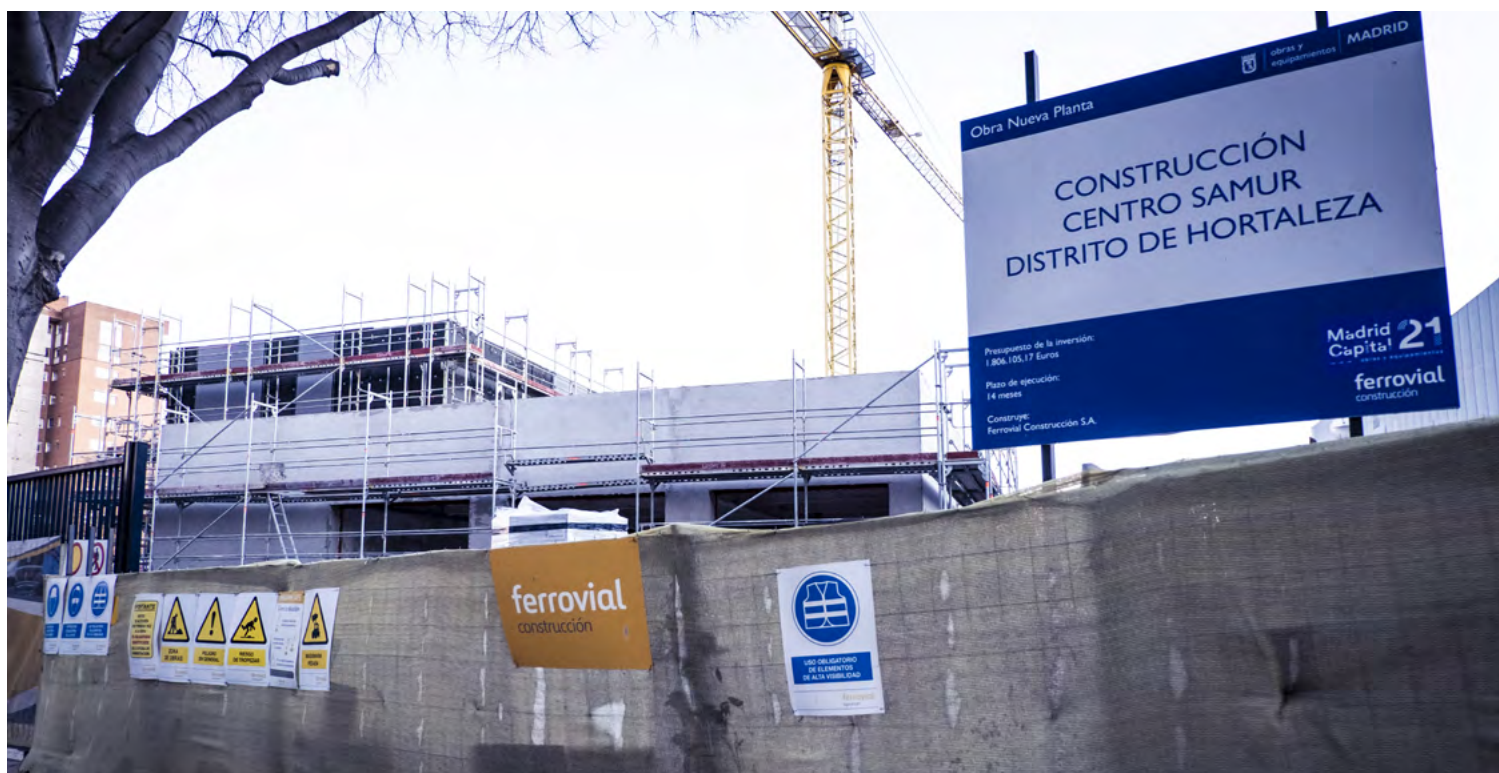
Construcción del nuevo centro del SAMUR para el distrito en Mar de Cristal, junto a la oficina de la Policía Municipal. SANDRA BLANCO
