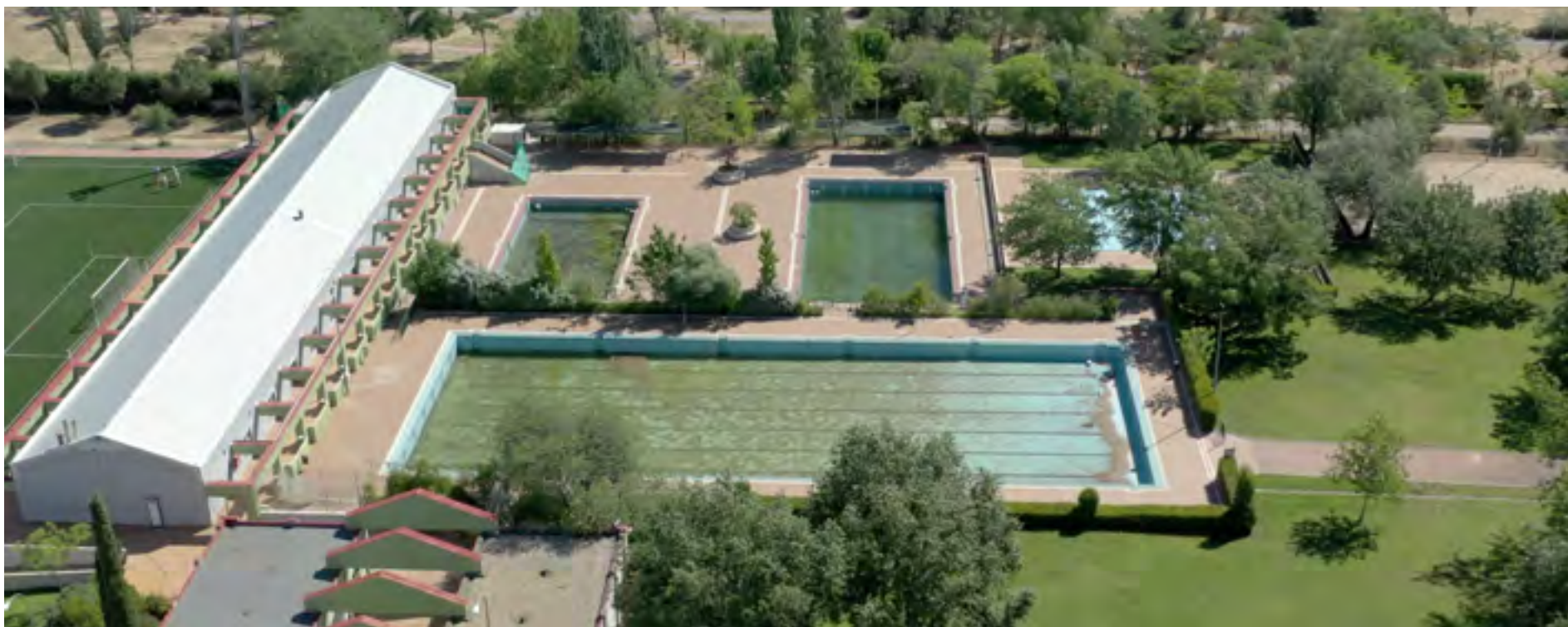
Estado actual de las piscinas del polideportivo Luis Aragonés. A la izquierda, el edificio en el que se realizarán las obras este verano. PLANORÁMICA
