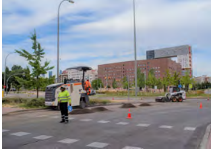
Trabajos de reparación en una calle de Sanchinarro. RODRIGO MÍNGUEZ
