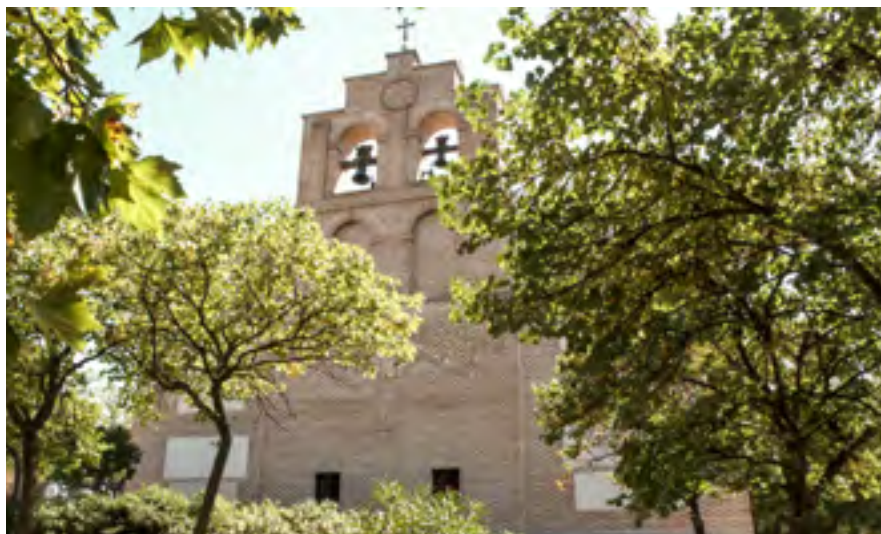
Aspecto actual de la espadaña de la ermita de San Blas, en la calle Montalbos, tras su restauración. JULIA MANSO
