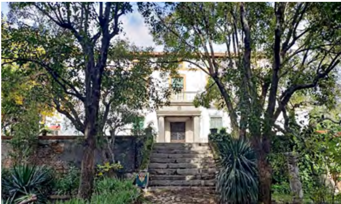
Fachada del palacete de Huerta de Mena, que permanece cerrada a cualquier visita desde hace diez años.
