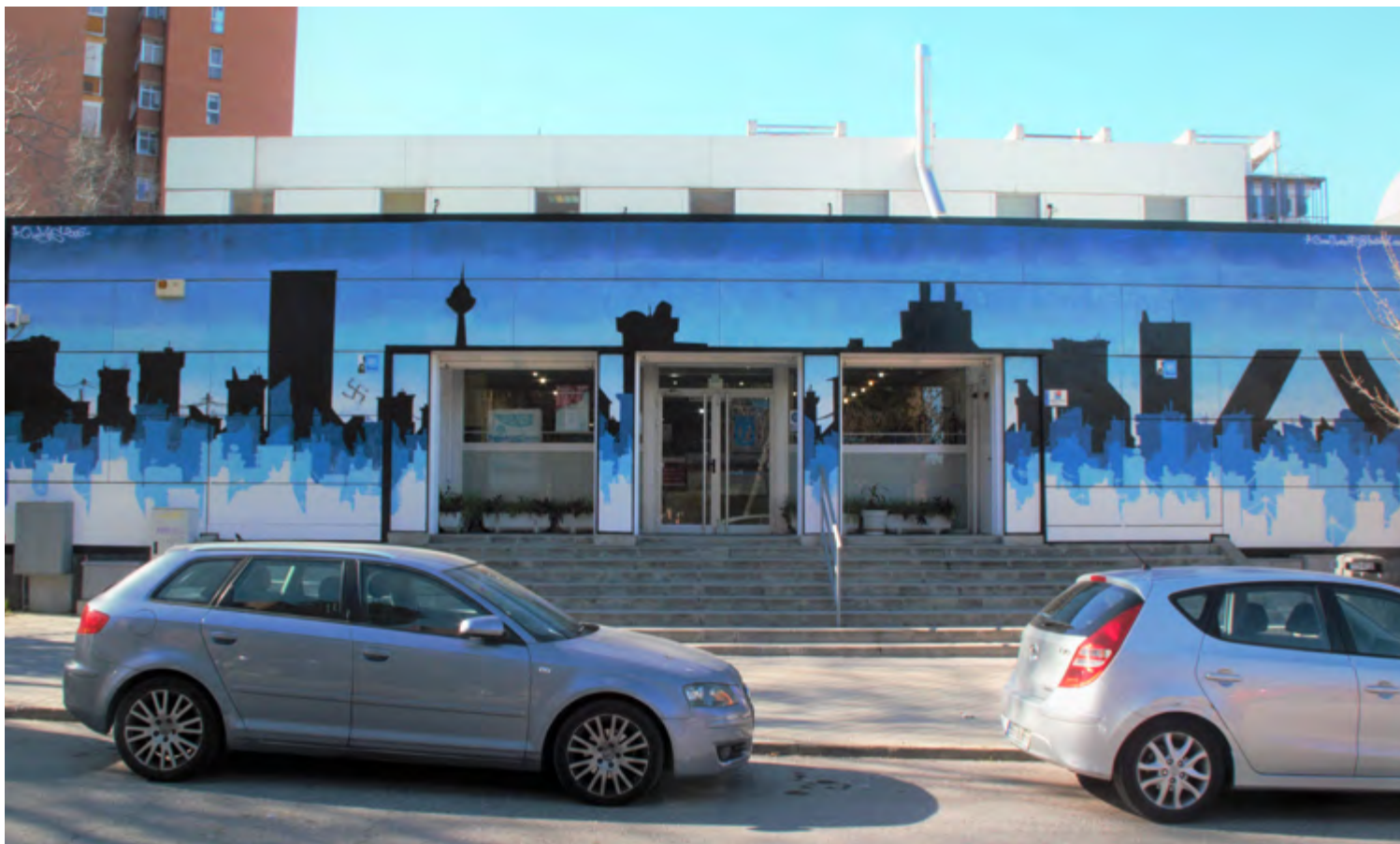
Fachada del Centro de Atención a las Adicciones (CAD) de Hortaleza, en la calle Minaya. JULIA MANSO
