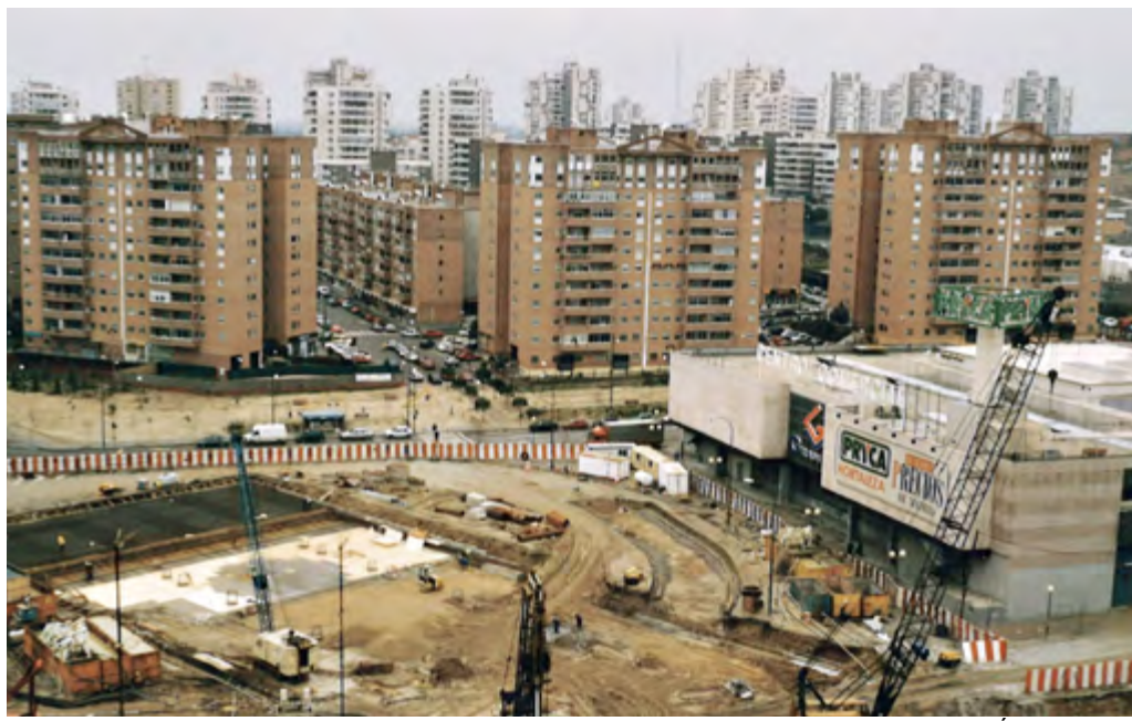
Obras de la estación de Metro en la glorieta de Mar de Cristal en los meses previos a su inauguración en 1998. ASOCIACIÓN VILLA ROSA
