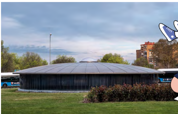
Cúpula sobre la estación Mar de Cristal, donde conectarán las líneas 4, 8 y 11 de Metro.
