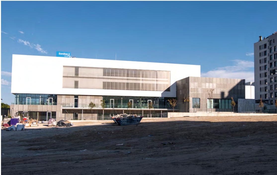
Estado de las obras del centro cultural de Valdebebas en el cruce de la calle Jordi Solé Tura, 34, con la avenida Manuel Fraga Iribarne. SANDRA BLANCO
